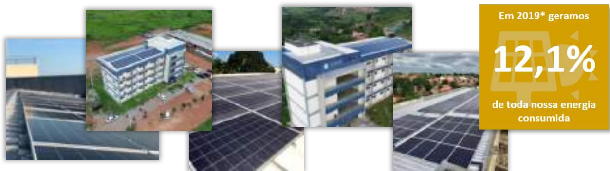
Figura 16: Usinas fotovoltaicas instaladas em 2019: Unidade II, Xinguara, Unid. III, Rondon do Pará e Galpão de Laboratórios.
